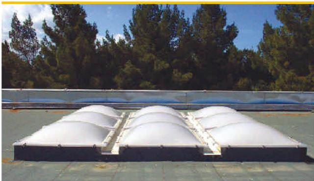
Le **gronde**, realizzate con gli stessi materiali e tipologie dei basamenti consentono il fissaggio di un lato del cupolino ed un'agevole deflusso dell'acqua.
