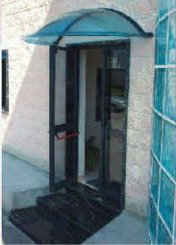
Realizzate per termoformatura autoportante di lastre monolitiche. Dotate di grondina perimetrale, si collegano alla muratura per mezzo di una centina in particolare profilo di acciaio zincato e verniciato. Sono prive di altre strutture metalliche portanti.
