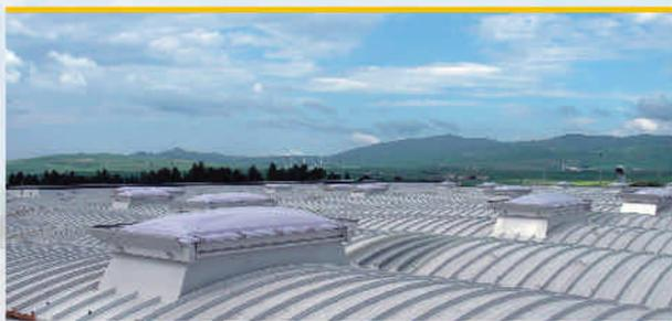
I **Basamenti** di supporto e di fissaggio al solaio possono essere ad angolo retto o avere forma tronco-piramidale. Realizzati con la parete interna in lamiera zincata verniciata bianca e la parete esterna in resina poliestere rinforzata da fibre di vetro ricoperta da uno strato protettivo di gel-coat bianco, ovvero l'una o l'altra parete interamente in vetroresina o in lamiera; la camera riempita da poliuretano espanso.
