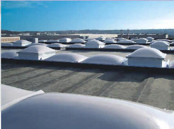
Costituiti da moduli termoformati con costolature di irrigidimento e accoppiamento a "maschio-femmina". Con questo sistema si possono coprire vani con larghezza stabilita e lunghezza su misure del cliente con passo anche di 1 cm. E' possibile dotare i Continui Componibili di dispositivi per apertura totale o parziale.
